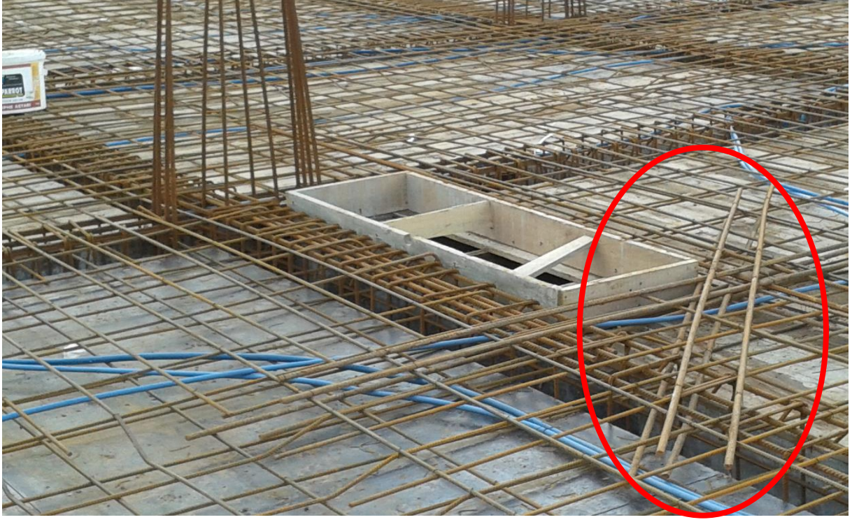
Fotoğraf 11: Döşeme Boşluk Donatılarının Kontrol Edilmesi
