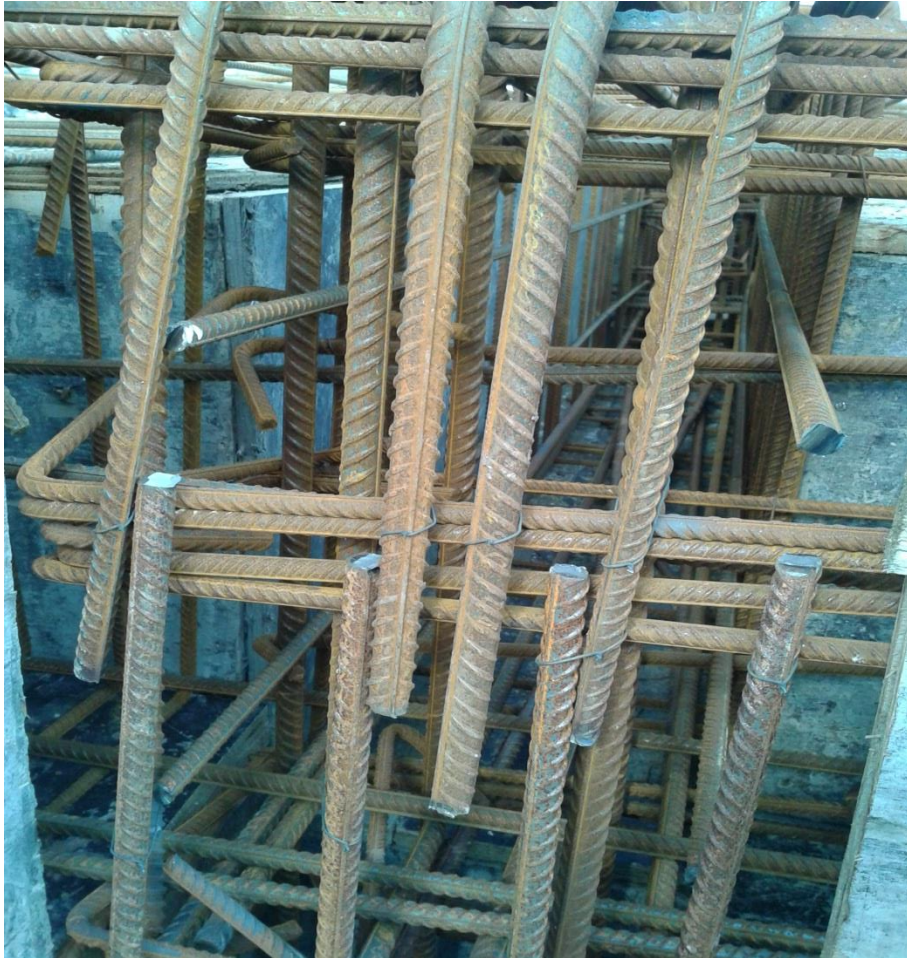
Fotoğraf 7: Kiriş Donatılarının Gönyelerinin Kontrol Edilmesi
