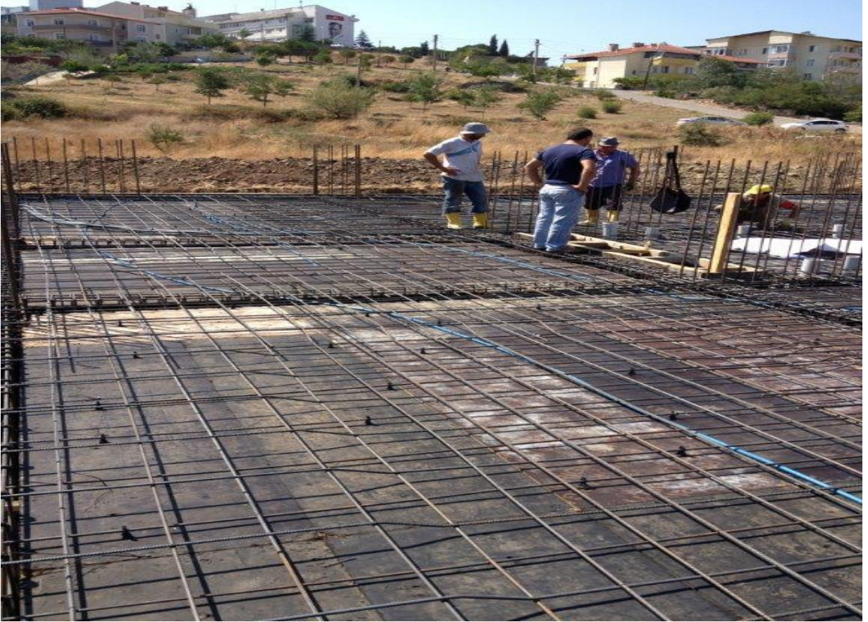
Fotoğraf 12: Pas paylarının Kontrol Edilmesi
