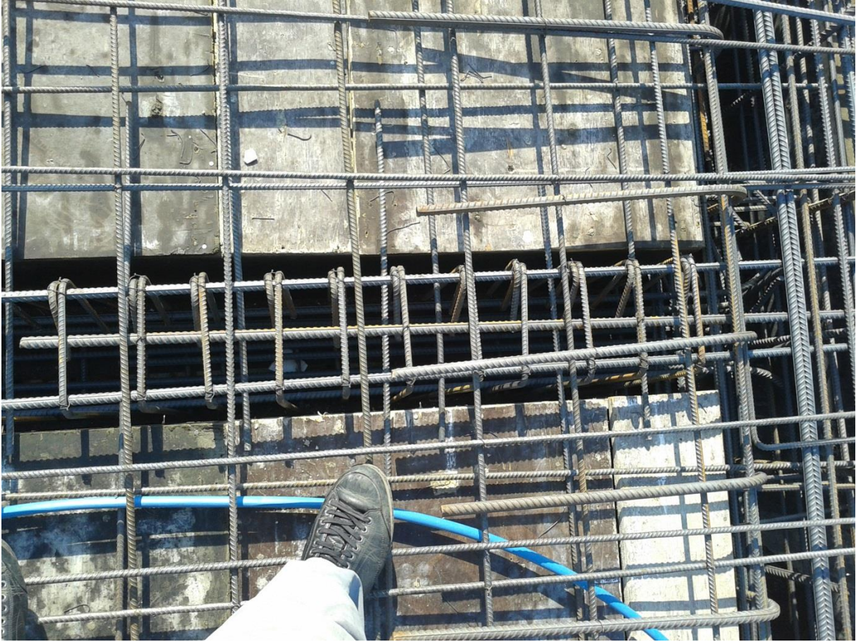
Fotoğraf 5: Kiriş Boyuna Donatılarının Kontrol Edilmesi
