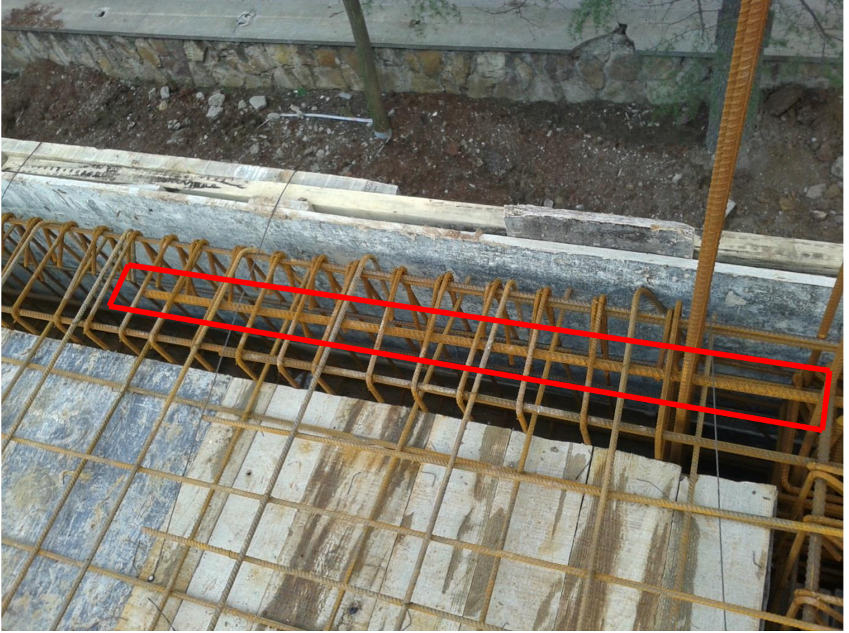
Fotoğraf 6: İlave Mesnet Donatısının Kontrol Edilmesi
