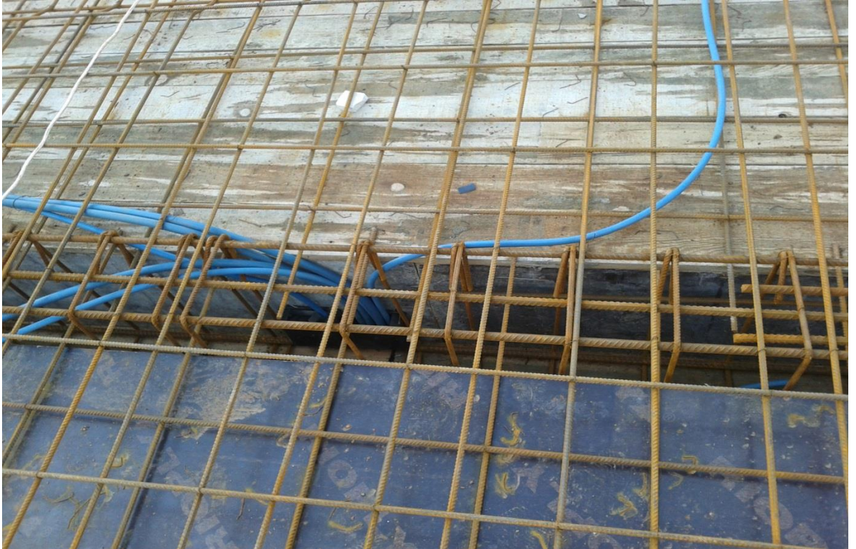
Fotoğraf 9 : Kiriş Etriyelerinin Kontrol Edilmesi
