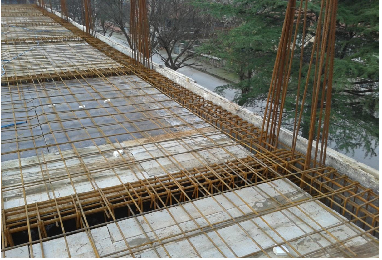
Fotoğraf 8 : Kiriş Etriyelerinin Kontrol Edilmesi
