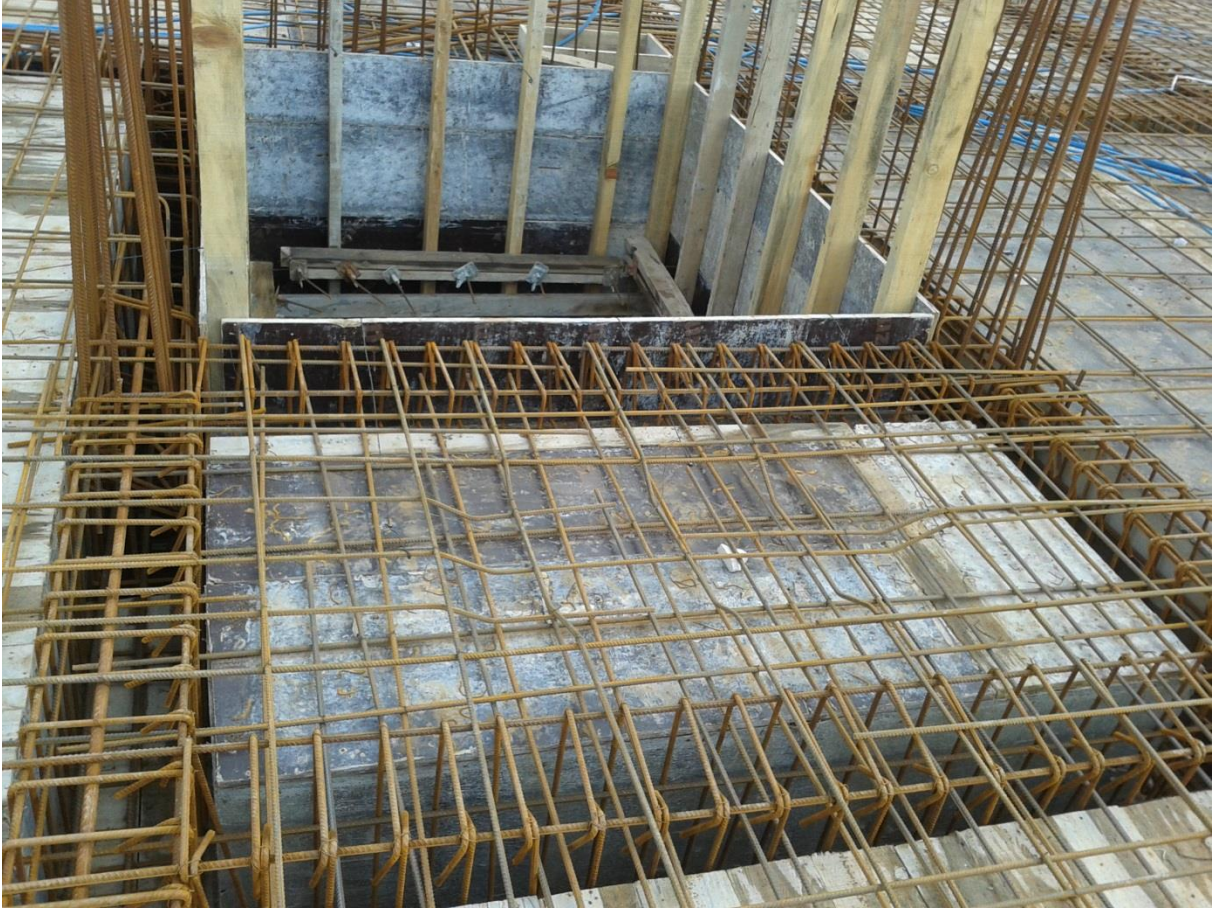
Fotoğraf 10: Döşeme Donatılarının Kontrol Edilmesi
